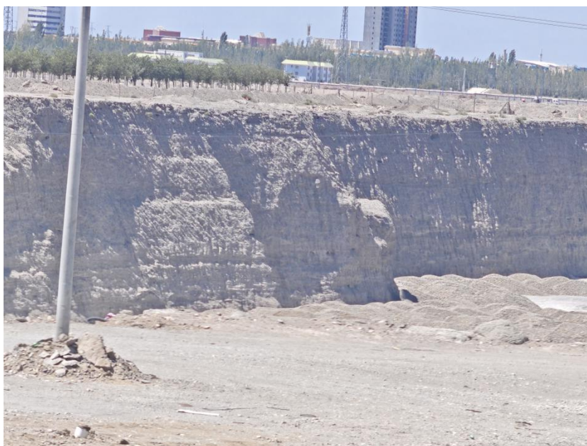
图 1-11 坑壁陡立边坡
