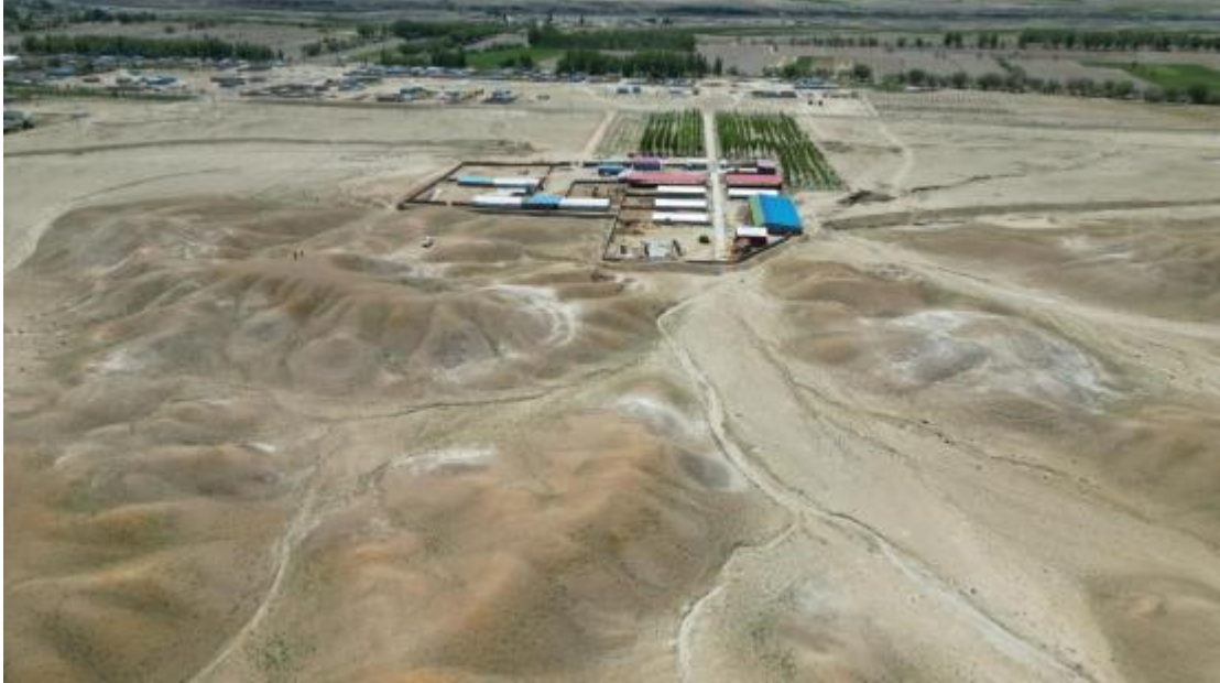
照片 3.4.1 泥石流沟下游及堆积区现状
